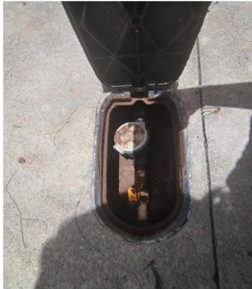
Figura 21, contador de agua potable
